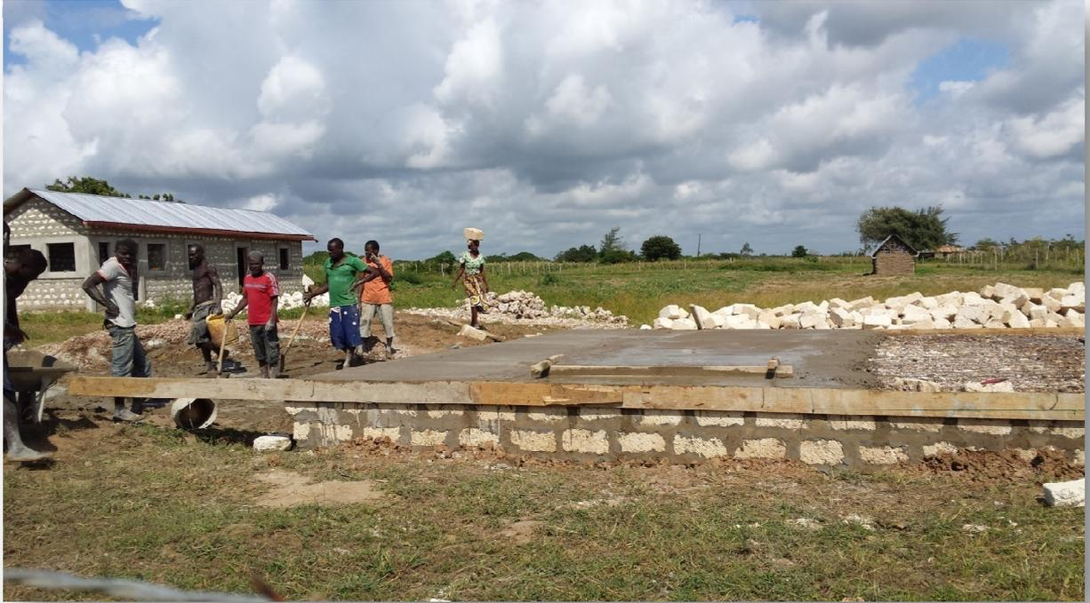
14 jours de travail pour : nettoyage et marquage de l'emplacement, terrassement, préparation (coffrage, pierres, ferrailles...) et coulage des fondations, préparation de la dalle de ciment (coffrage, pierres, ferrailles...) et coulage de la dalle.
